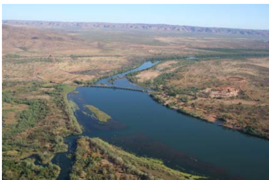
The Diversion Dam and Lake Kununurra, Kununurra
